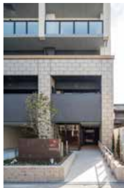
〈スロープ・手すり〉
