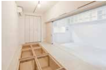
〈逆梁工法を利用した床下収納〉
